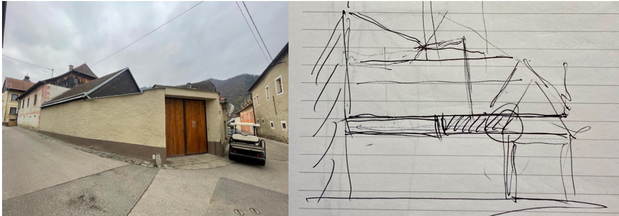
Abbildung 36/37: Bestandsfoto Wirtschaftshof, Erstskeizze zur möglichen Aufstockung, Atelier Körner Ausgangssituation:
